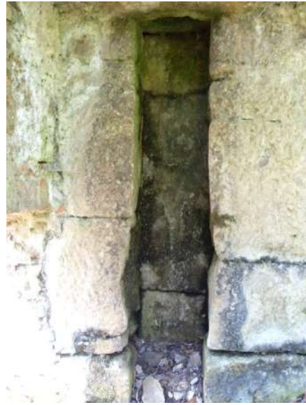
Fig. 36. Lungro, località Konxa : incanalamento idrico del mulino.
