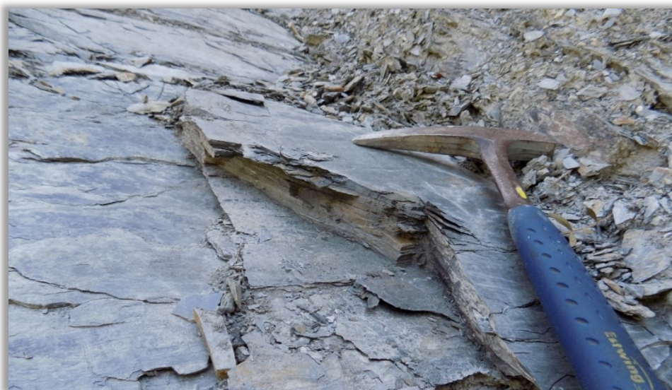
Fig. 4.3 – Filladi dell'Unità di Bocchigliero (Ovest di Scala Coeli).
