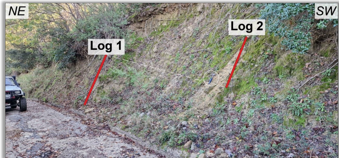
Fig. 6.16 – Affioramento Stazione 7 (356 m s.l.m.).
