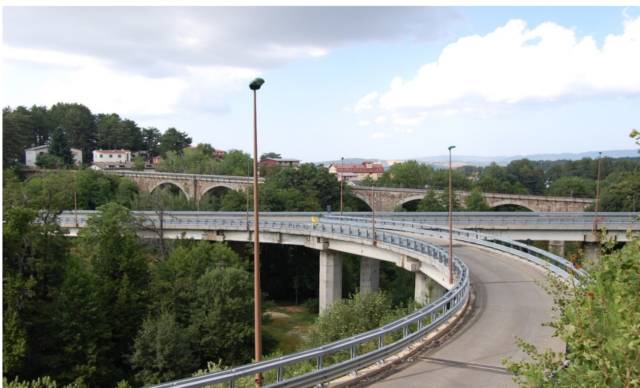
Figura 3.13: Viadotto Camigliati, luglio 2021
