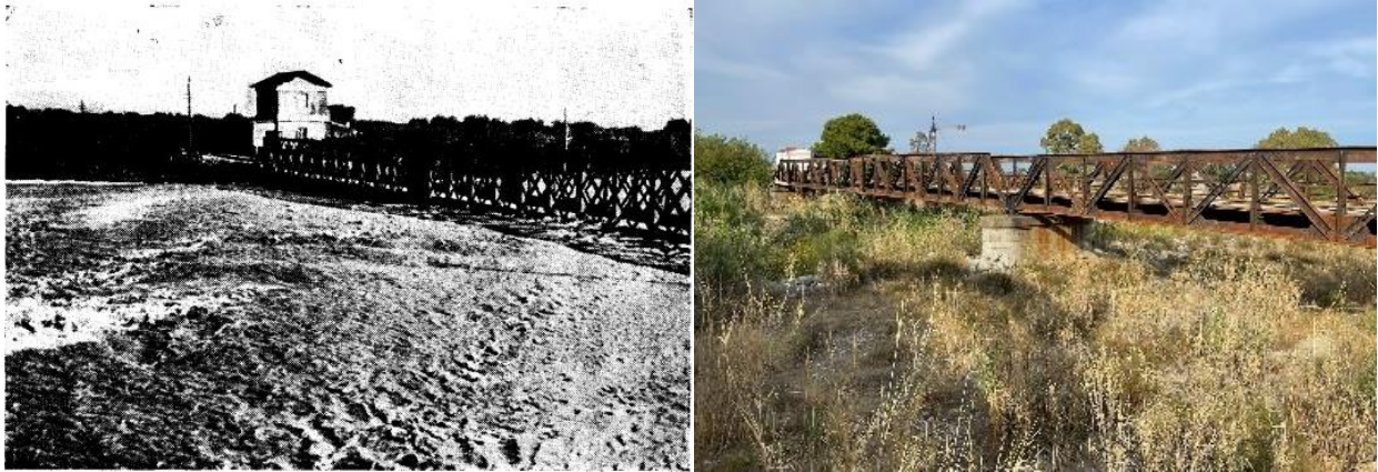
Figura 2-5: Sormonto del ponte sull'Alaco. A fianco il ponte sull'Alaco in una foto recente
