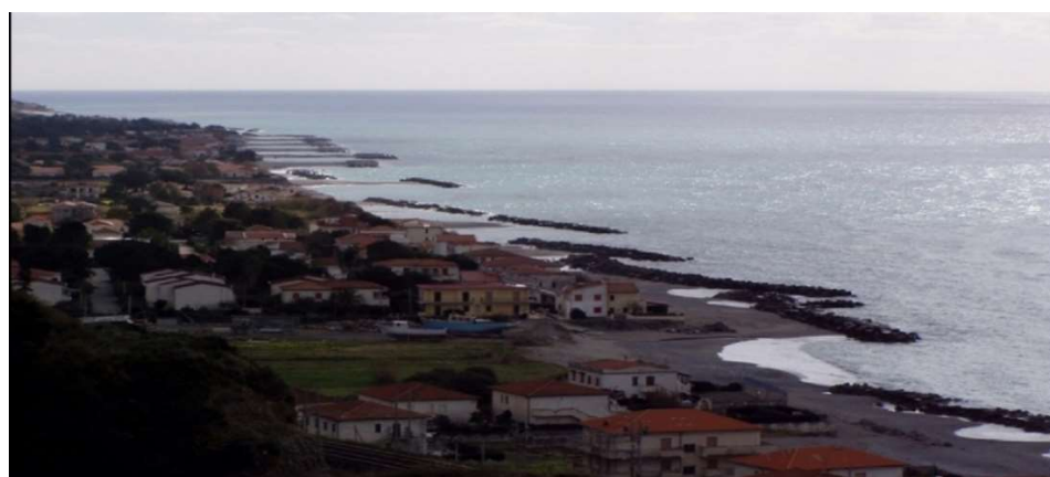
Figure 3-18. Vista della spiagge di Calabaia, subito prima dell'intervento di ripascimento, difesa da scogliere emergenti, rimosse successivamente a dicembre del 2002. (da Maiolo et al. 2020)
