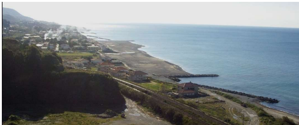
Figura 3-23 . Lavori completati sulla spiaggia di Calabaia (dicembre 2006) (da Maiolo et al. 2020)
