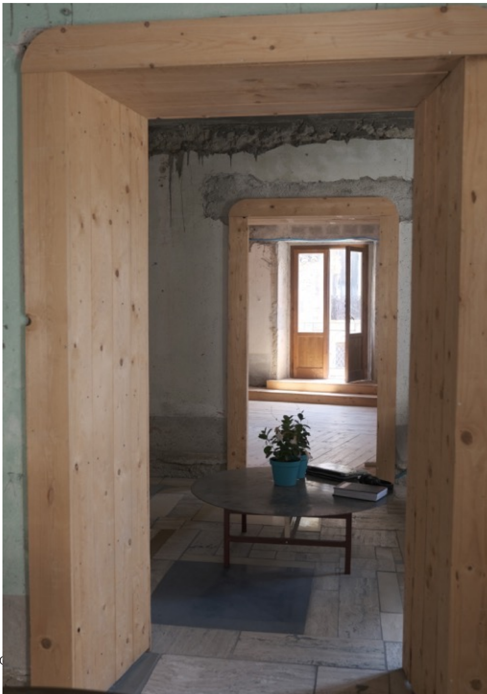
Cantiere Belmondo - Belmonte Calabro (archivio di campo)
