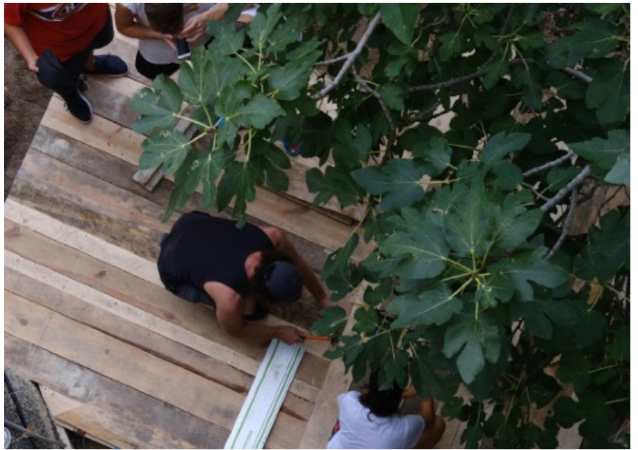
Cantiere Belmondo - Belmonte Calabro (archivio di campo)
