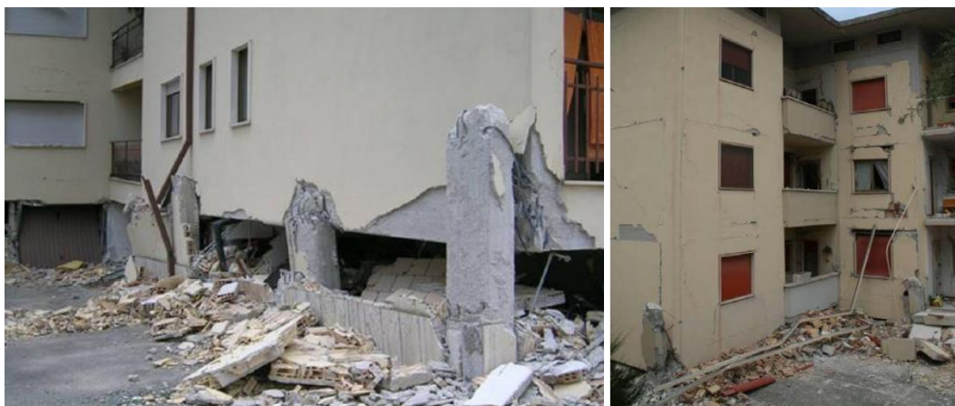
Figura 2.13 – Collasso di un edificio multipiano per soft-storey (ReLUIS - L'Aquila, 2009).
