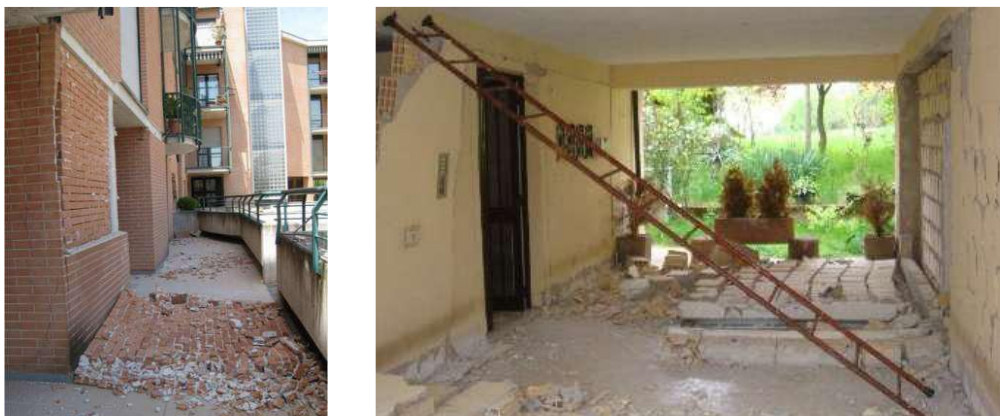
Figura 2.21 – Espulsione OOP di una singola fodera (a sinistra) esterna e (a destra) interna (L'Aquila, 2009 - Furtado et al., 2016b).
