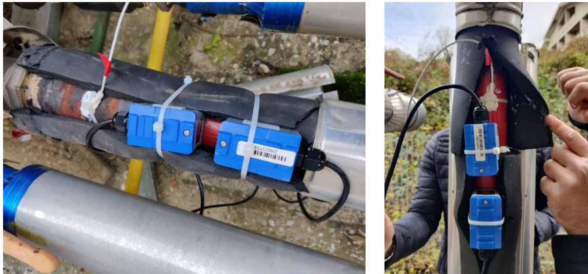
Figura 4.12 Montaggio dei trasduttori su tubazioni orizzontali e verticali
