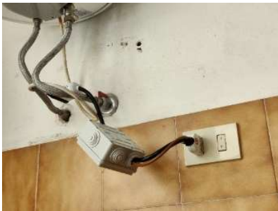
Figura 5.25 Installazione Shelly EM ai boiler per la produzione di ACS
