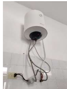
Figura 5.25 Installazione Shelly EM ai boiler per la produzione di ACS
