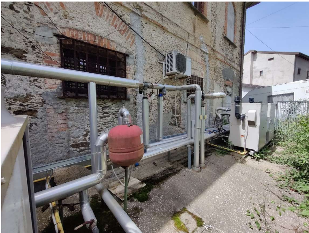
Figura 4.9 Impianto geotermico a servizio dell'edificio comunale e dell'ufficio tecnico del comune di Soveria Mannelli
